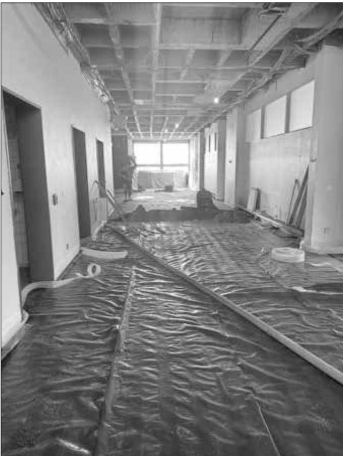
Die Sanierungsarbeiten nach dem Wasserschaden sind im vollen Gange. Der Estrich im Obergeschoss ist entfernt und erneuert worden und ab 21.03.2022 hat die neue Abbruchfirma ihre Arbeit aufgenommen, um die Betonschneidearbeiten durchzuführen.
