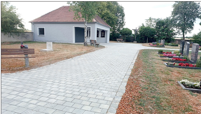
Leichenhalle und Zugang lobenswert saniert.
